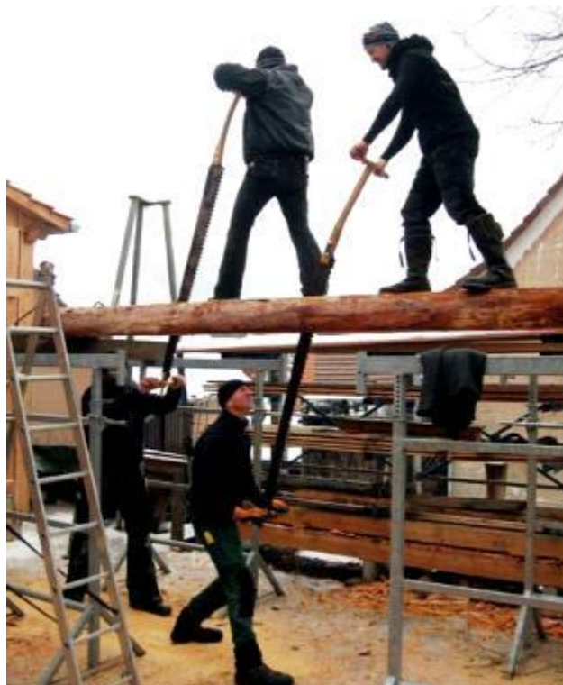
Die Schneidetechnik mit der Klobasse (alte Klobassen sind in einen Rahmen eingespannt)
