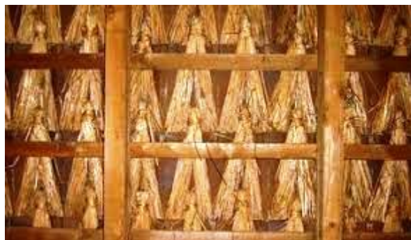
Innenansicht eines mit Schöpfen versehenen Tonziegeldaches
